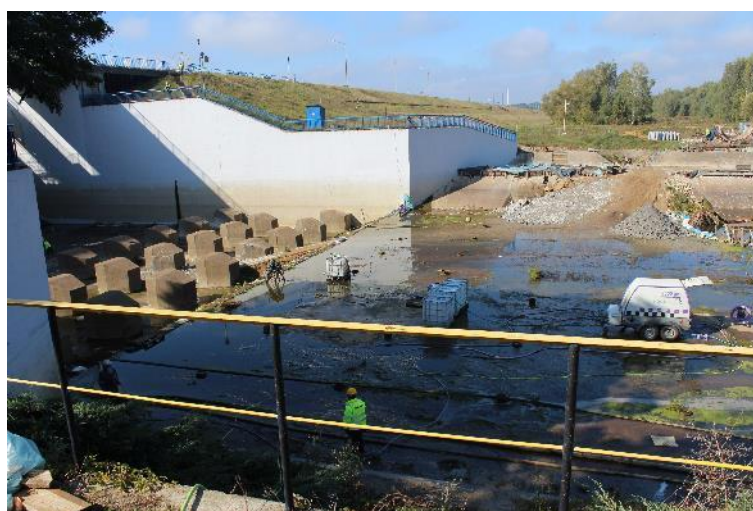
Remont dolnego stanowiska zbiornika Jeziorsko (zdj. SITWM)
